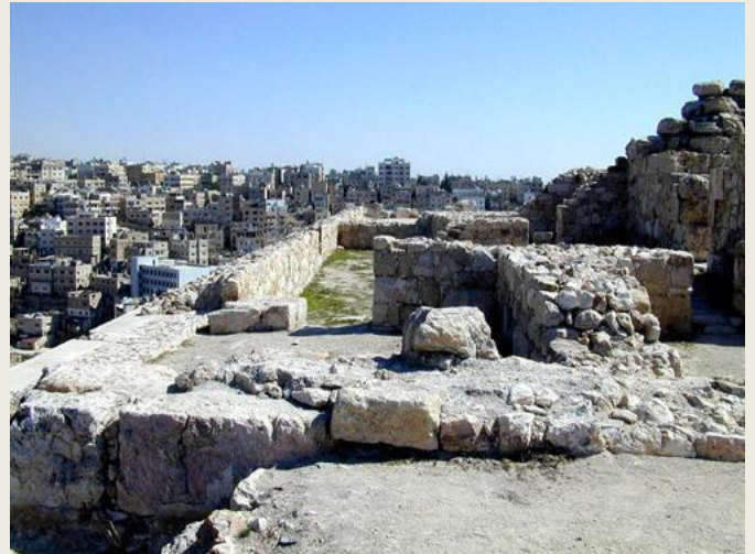
安曼卫城的防御工事
