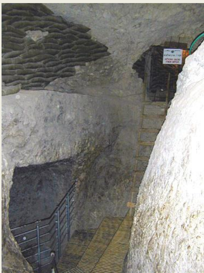
华伦竖坑入口至通往水塔的隧道
