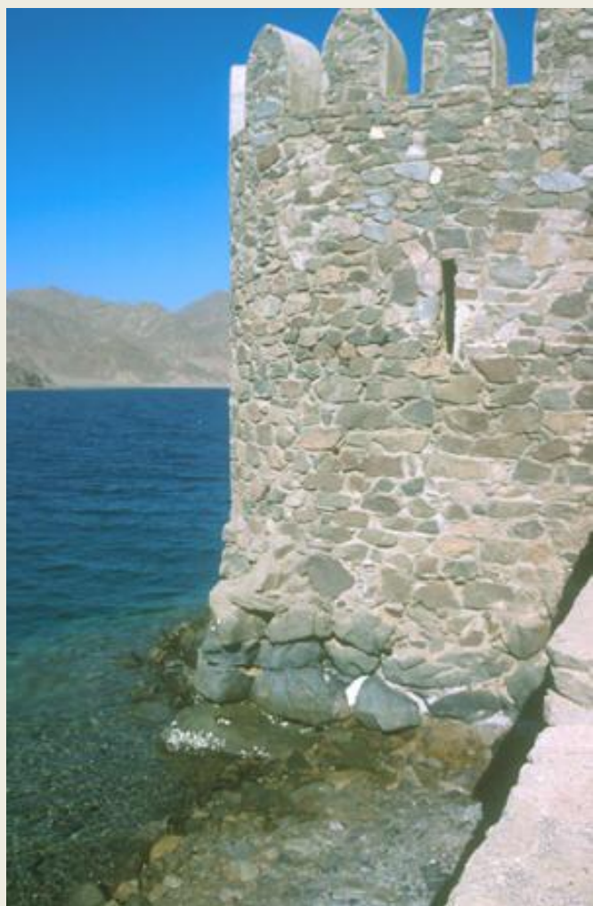
珊瑚岛上塔楼的古老地基
