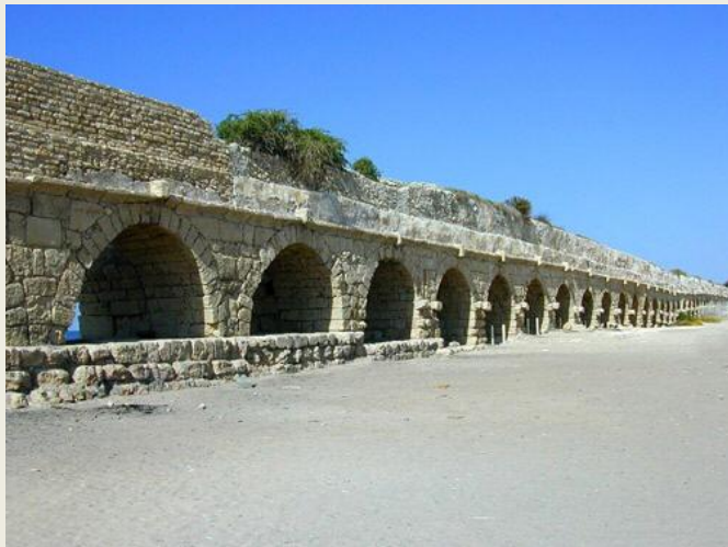
罗马在该撒利亚建筑的引水桥
